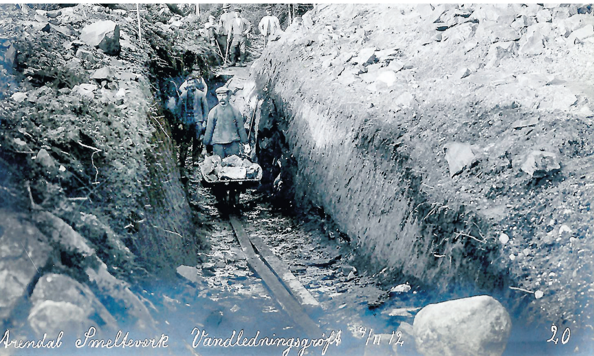
Fra anleggstiden ved Arendal Smelteverk. «Vandledningsgrøft 4/11-12».
