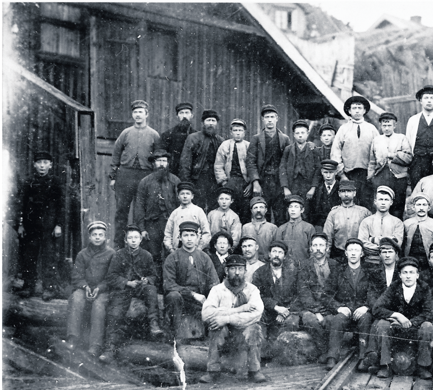
Arbeiderne på Strømsbuneset verft. Strømsbuneset verft ble anlagt av Lauritz Christian Stephansen (1801-1863) fra Tjølling ved Larvik. Han på Strømsbuneset. Han fikk bygd bl. a. det store klipperskipet «Oceana» på 200 kml, som da var da Norges største.
