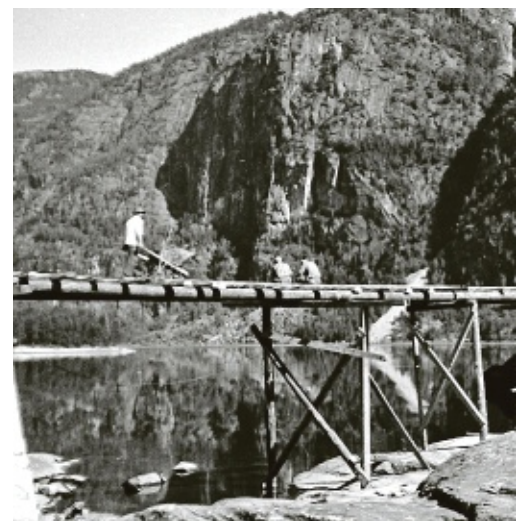
Brua frå Helle over til Straume var under bygging sett bygt «manuelt». Her støyper dei ein kunne kvile på.
