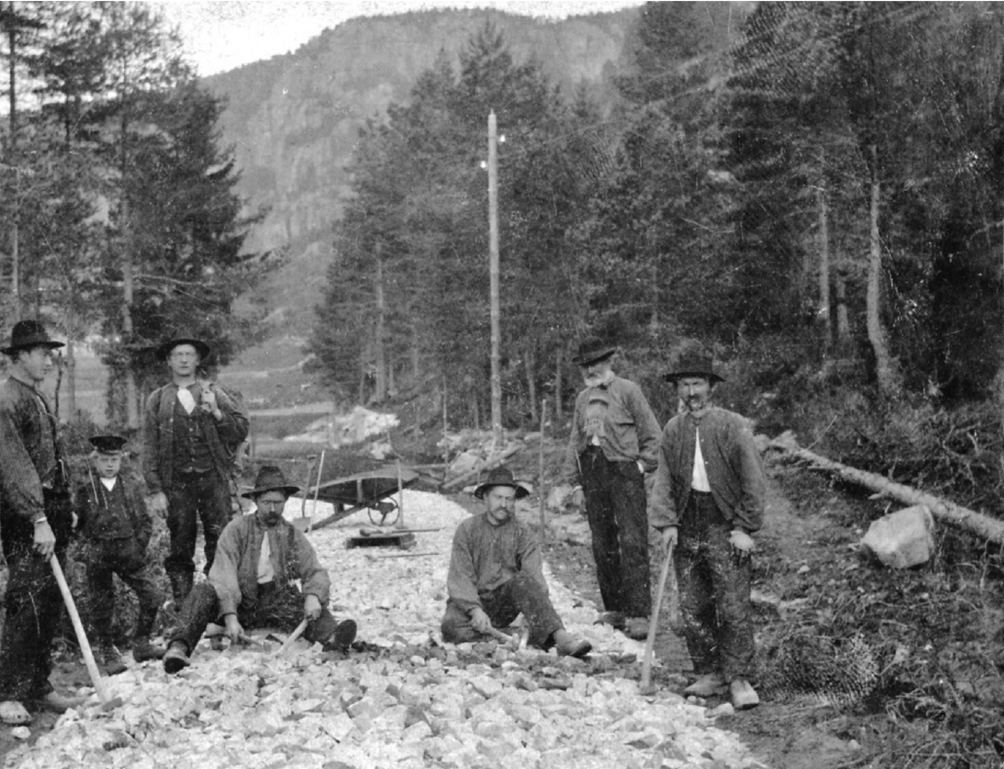
ging då Georg Johnson vart vegmeister i 1827. Det vil seie at ein la eit 25 cm tykt lag med pukkein på vegen for å auke bereevna. Desse karane arbeider på Arendalsvegen like aust for Hovland i
