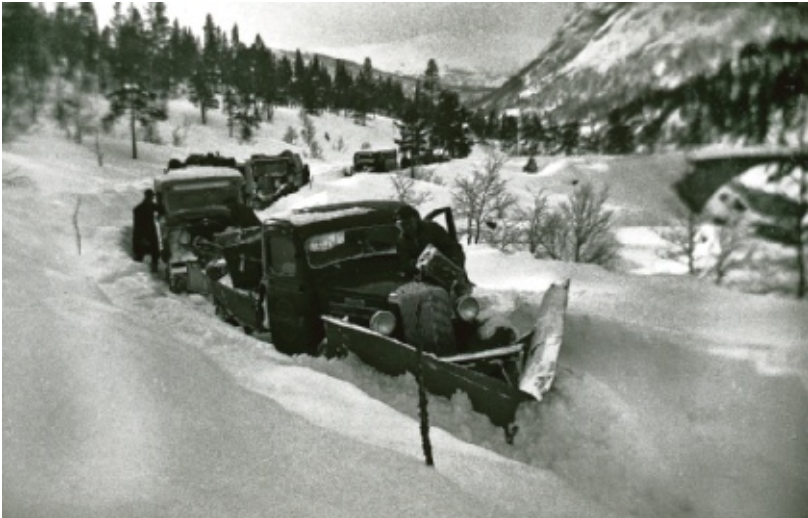
Straks vegen til Hovden stod ferdig, begynte arbeidet med å byggje det fyrste Hovden Høyfjellshotell. Denne kolonna er på veg opp med materialar og utstyr og har teke ein stopp på Berdalsbru for å fylle vatn på radiatoren. Risikoen for møtande trafikk truleg var minimal. (ca. 1935) FOTO: LARS LIESTØL/SETESDALSMUSEET
