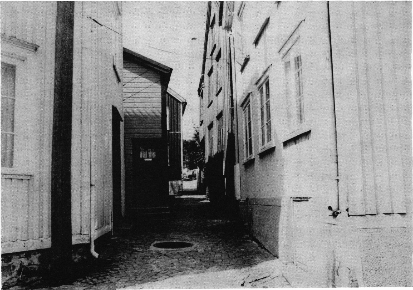
Intimt boligmiljø. Til høyre matr. nr. 245 og 247, til venstre matr. nr. 246 B og 246 A.
