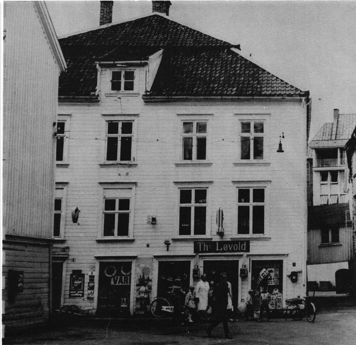
Matr. nr. 223/224. Sammenbygning av to hus med gavler mot Pollen, derfor den uvanlige takform. På baksiden av huset viser panelingen skillet mellom de to bygningene. (Jfr. bildet av matr. nr. 225 fra 1872).
