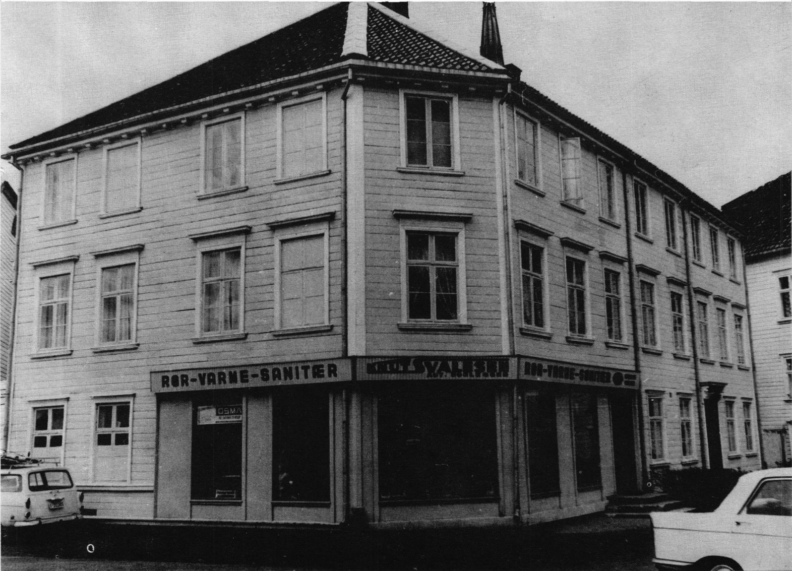
Matr. nr. 222 A og B. Eldste bygningsdeler trolig fra 1658. Fasadeutformingen slik den nå er ble gjort i midten av forrige århundre. Butikkfasaden passer dårlig til bygningsmiljøet.
