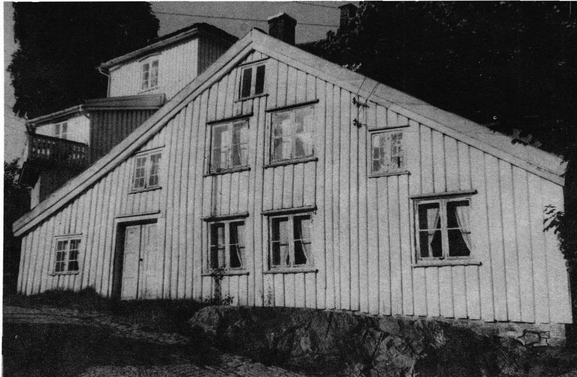
Matr. nr. 255 C er en karakteristisk bygning, muligens fra før 1700-tallet. Bygningen trenger omfattende reparasjoner snarest.
