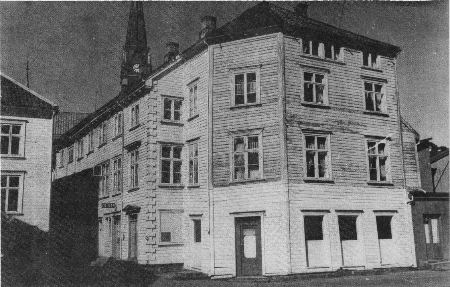
Matr. nr. 209 A. Eldste bygningsdeler fra 1660-årene. Huset preges av empire- og sen 1800-talls bygningsstil.
