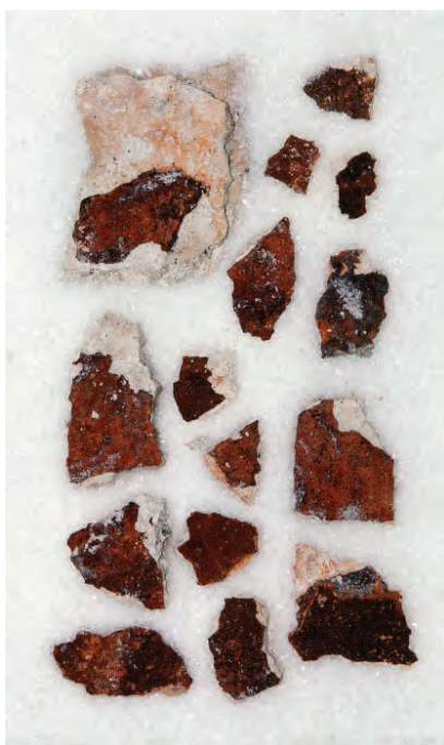
Fig. 17. Rødbrun kalk fra 1797 på sydveggen av Fjære kirke. Kirken fikk denne farve for ikke som sjømerke å bli forvekslet med Tromøy kirke og Risørflekken.
