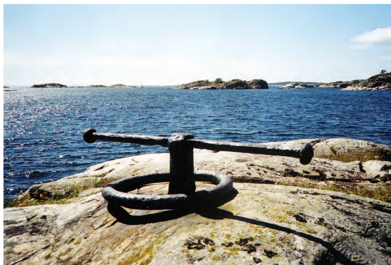
Fig. 7. Fortøyningsringen fra 1804 på Store Sandvikholmen sett mot uthavnen i sydvestlig retning. Ringens indre diameter er 53 cm, ytre diameter er 65 cm. Den horisontale stang er 115 cm, høyden av pålen er 33 cm. Den engelske fregatten fortøyd i en eldre ring som var satt ned på det samme sted.
