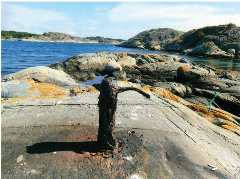
Fig. 11. Fortøyningspålen på Ruholmskjæret sett mot nordøst, den er sterkt preget av tidens tann. Den ble satt opp i 1804. Høyden av pålen som står igjen, er 43 cm. En eldre fortøyningsring på samme sted, ble brukt i år 1800 av en av de mindre skutene.
