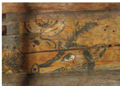
Tømmerkjernen i Merdøgaards sjøbod er laftet av gjenbruksmaterialer. Salteboden i sjøboden er uten vinduer. Her ble det oppbevart mat, og her foregikk slakting. Flere stokker har dekormaling fra et tidligere hus, kanskje en sal, satt vilkårlig opp da de ble gjenbrukt. Her ser vi dekorerte stokker som er gjenbrukt da boden ble bygd. Foto: Karl Ragnar Gjertsen. AAKS.DF.2007.02.
