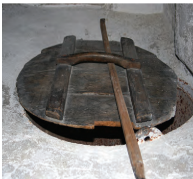
Lokket på den innmurte bryggerkjelen på Merdøgaard.
