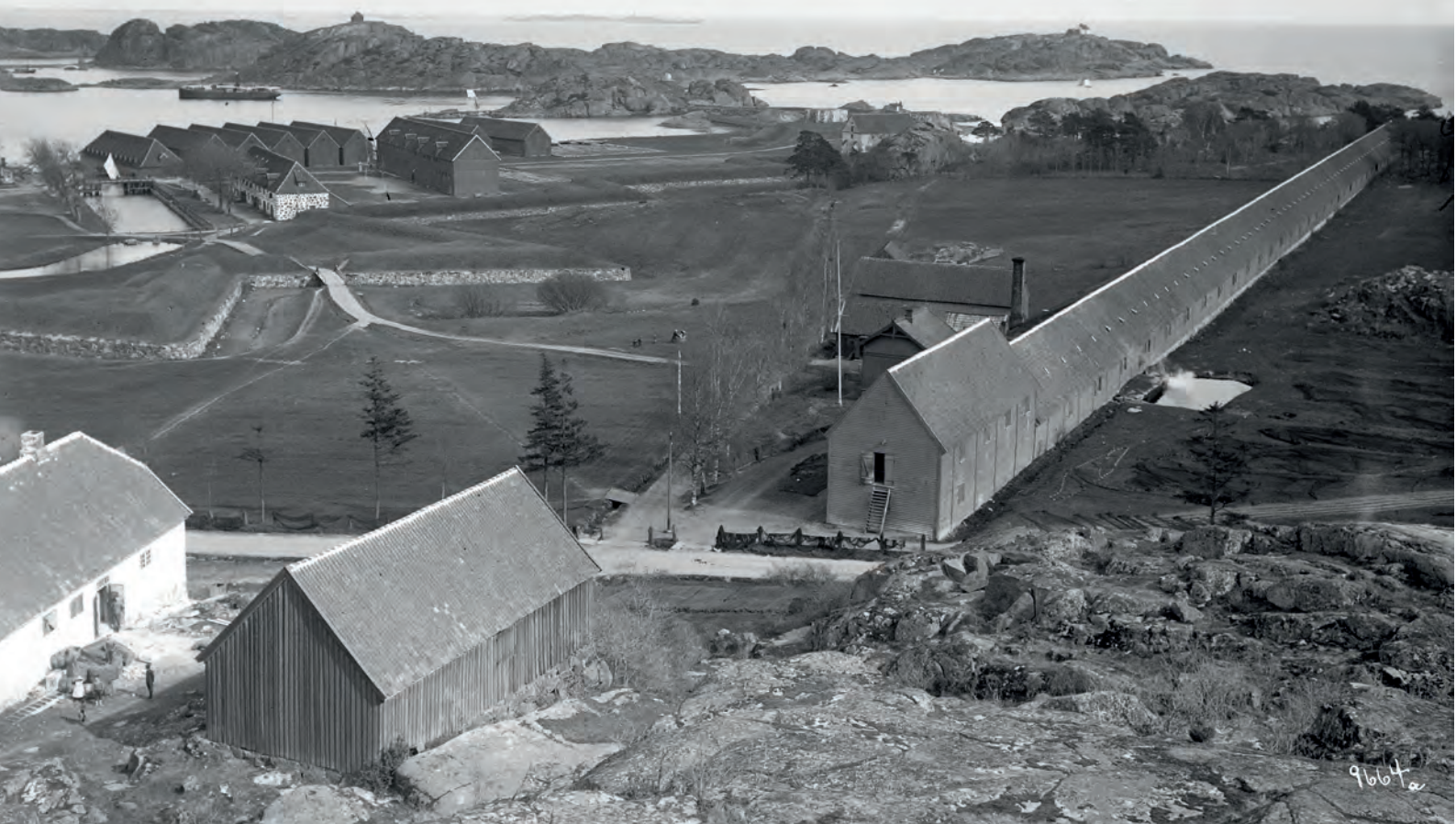
Fredriksvern reperbane i Stavern, der Emil Olsen var deleier. Trolig ble en del av tauverket til verftet på Risøya levert herfra. Bildet er tatt av Narve Skarpmoen på begynnelsen av 1900-tallet. Arkiv: Nasjonalbiblioteket.
