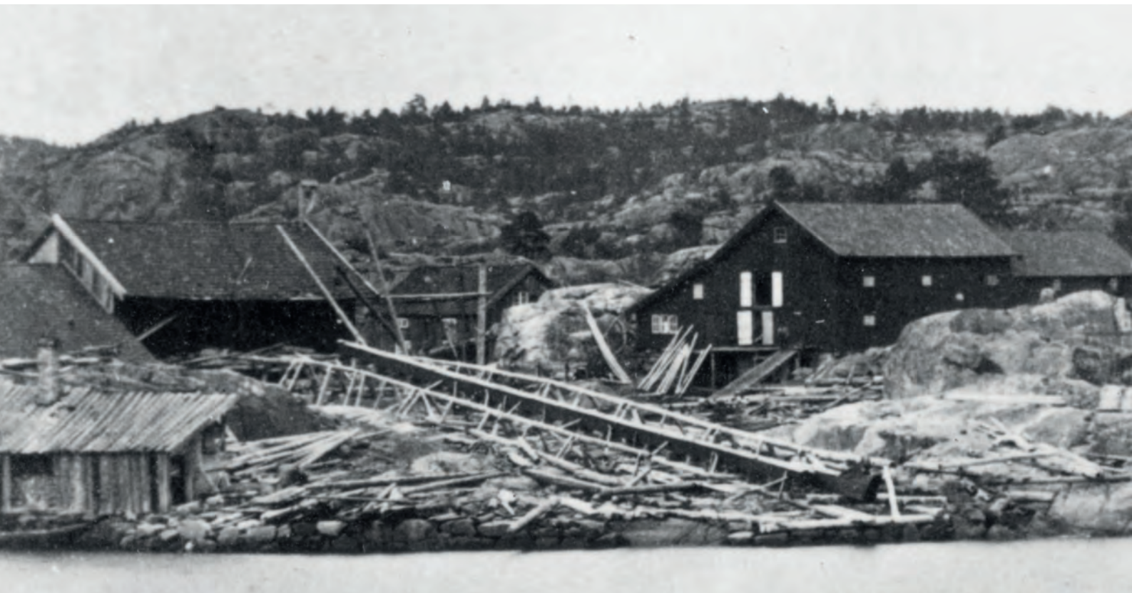
Utsnitt fra bildet fra 1875 med de to bodene på Holmen. I forkant til venstre ses skuret som kan ha vært kokerenna på Holmen. Bak i midten skimtes den store smia som ble ført opp på midten av 1860-tallet, og til høyre ses det store bodkomplekset som lå nedenfor Kronstad. Arkiv: Gunnerus – Spesialsamlinger ved NTNU Universitetsbiblioteket, F-II-Digital-6724.
