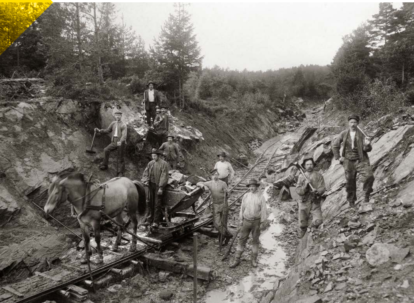
Arbeid på Arendalsbanen ved Solborg i 1902. Foto: Magnus Løvfold. PA-2436
